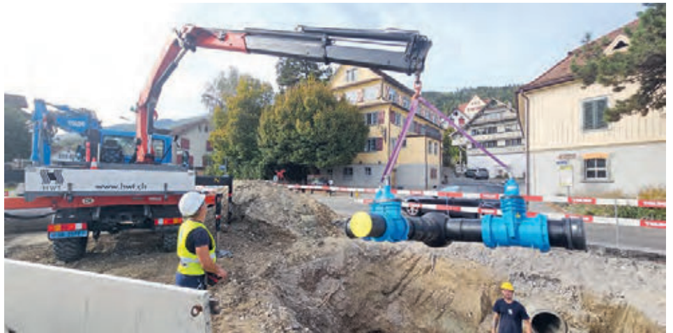
Installation des neuen Verteilerkreuzes an der Rösslikreuzung.
