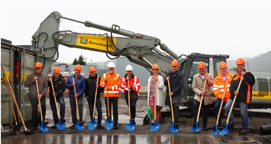
Vertreterinnen und Vertreter aus Politik, der beteiligten Planungs- und Baufirmen sowie Mitarbeitende der ARA Rosenbergsau vollzogen am Mittwoch bei strömendem Regen den symbolischen Spatenstich für den Bau der vierten Reinigungsstufe / Bild: Ralph Dietsche, radikom
