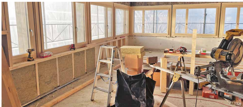
Innenausbau im Kindergarten Eichholz
