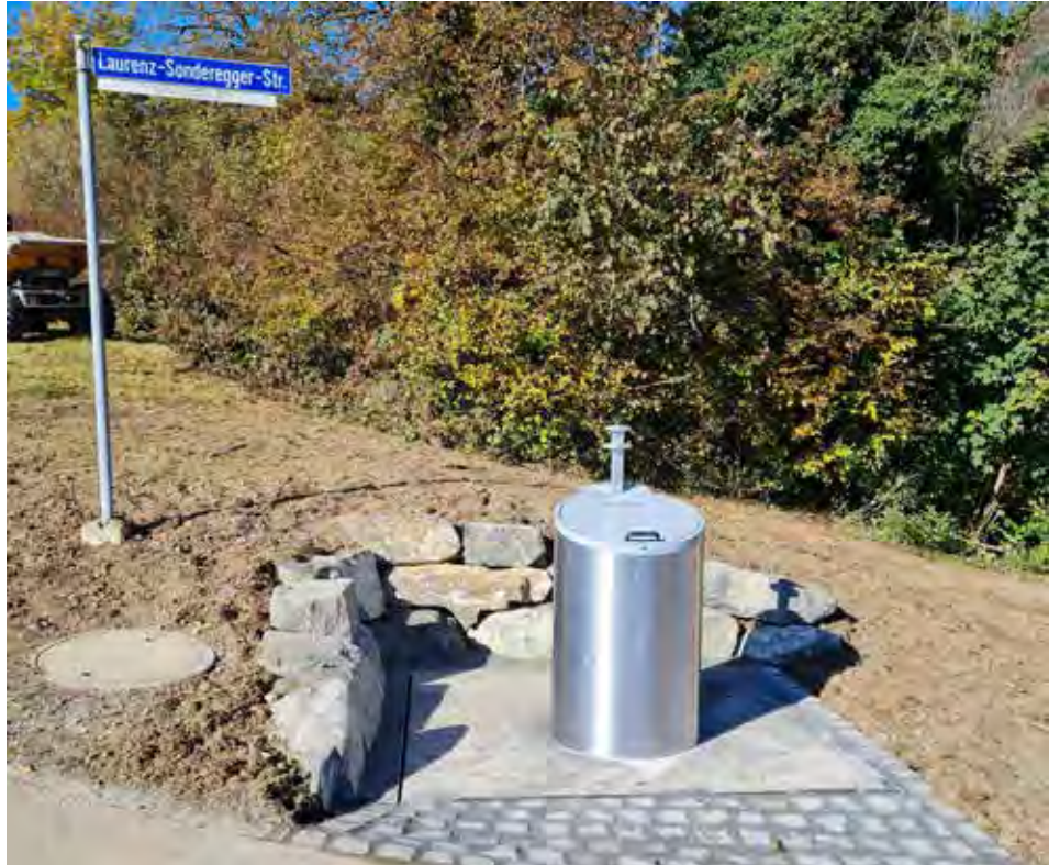
Unterflursystem an der Laurenz-Sonderegger-Strasse
