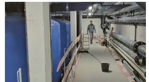
Technikraum während der Renovierung.
