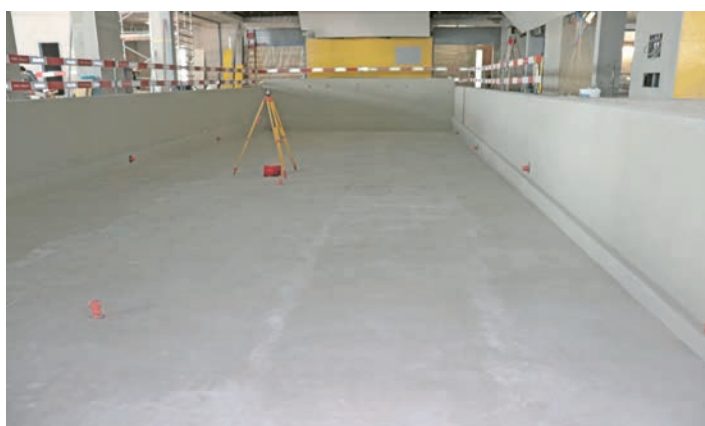
Das bisherige Schwimmbecken.
